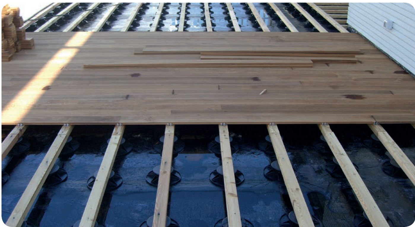
ОПОРА В ВИДЕ ДОМКРАТА Непрерывная миллиметрическая настройка
