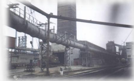
Антикорозійний захист трубопроводів матеріалом Fibre-Prime в м. Маріуполь, схильного до впливу корозійно-небезпечного навколишнього середовища. 9 років експлуатації - без проблем!
