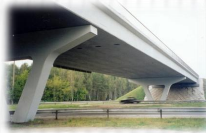
Ремонт і відновлення 4-х мостів по дорозі Київ-Бориспіль із застосуванням мокрого торкрет бетону Spray-Con WS ST. 10 років експлуатації - без проблем!
