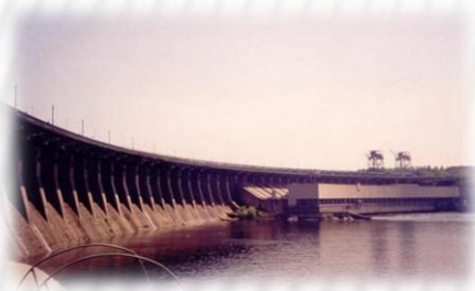
Ремонт ДніпроГЕС торкрет бетонами Spray-Con
